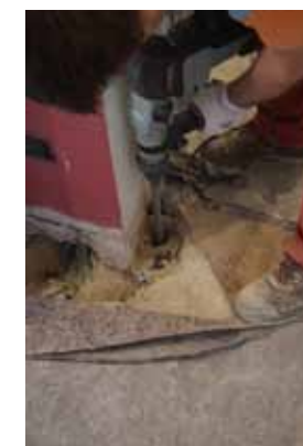
Fase di foratura del sottofondo fino a 65 cm.
