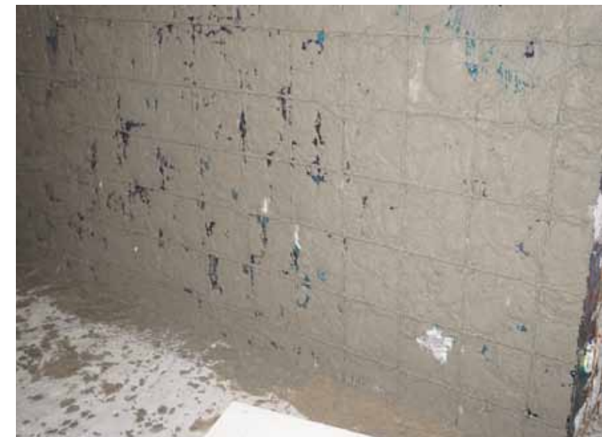
Fase di realizzazione intonaco su rete
