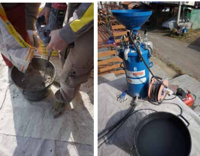
Fase di preparazione della malta fluida
