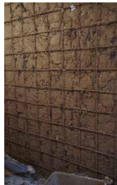
Rete elettrosaldata cm 15 x 15, diametro \varnothing 6
