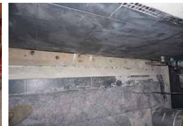
Fori eseguiti lungo tutto il perimetro esterno del paramento murario
