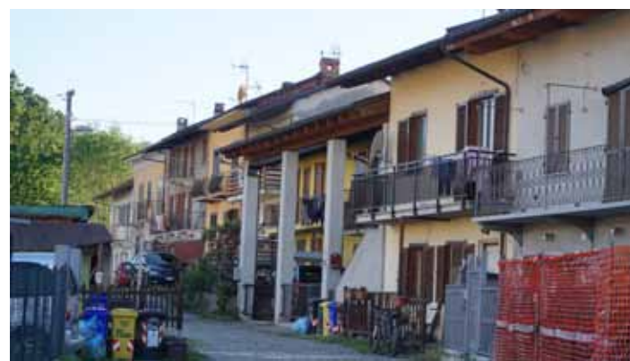
Vista generale dell'aggregato edilizio
